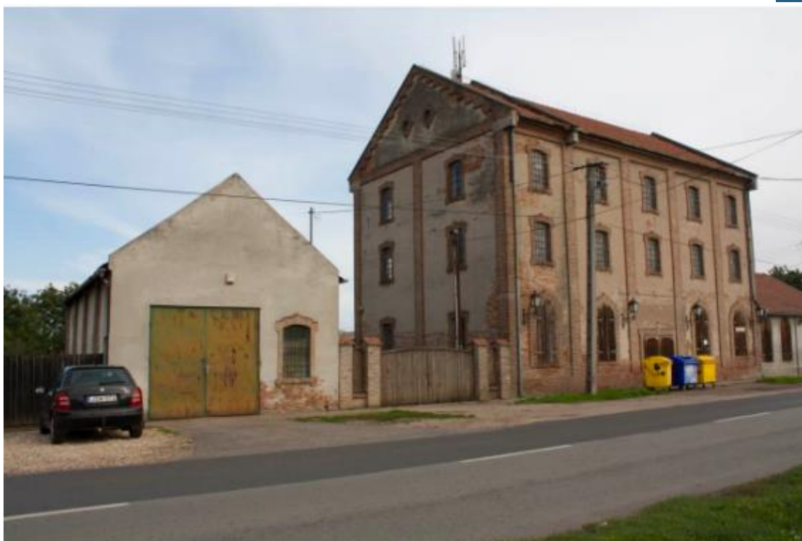
94. ábra: Elek, Malom épület
